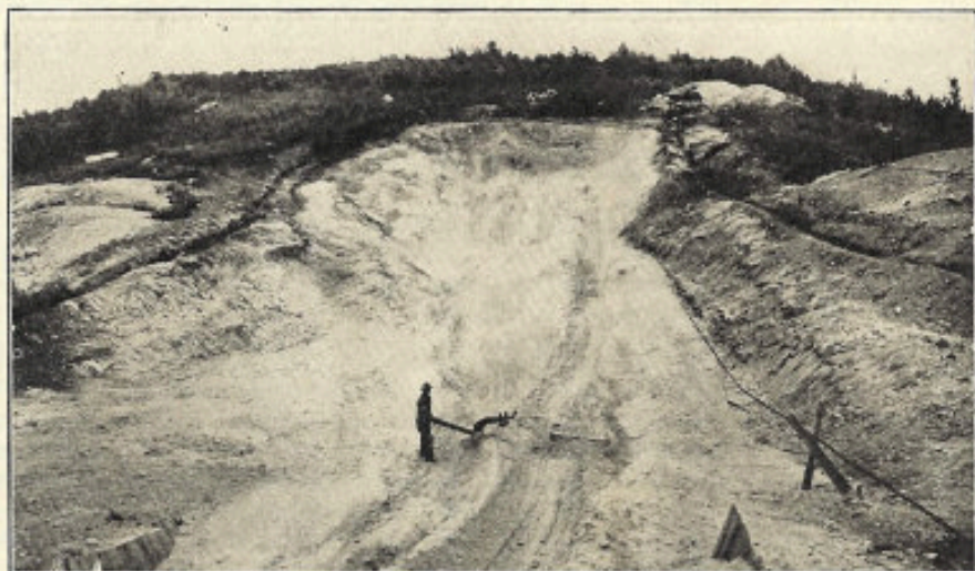
Fig. 89. — Pierre à monuments dans la carrière Brodie. Noter l'espacement des trous de perforatrice.
