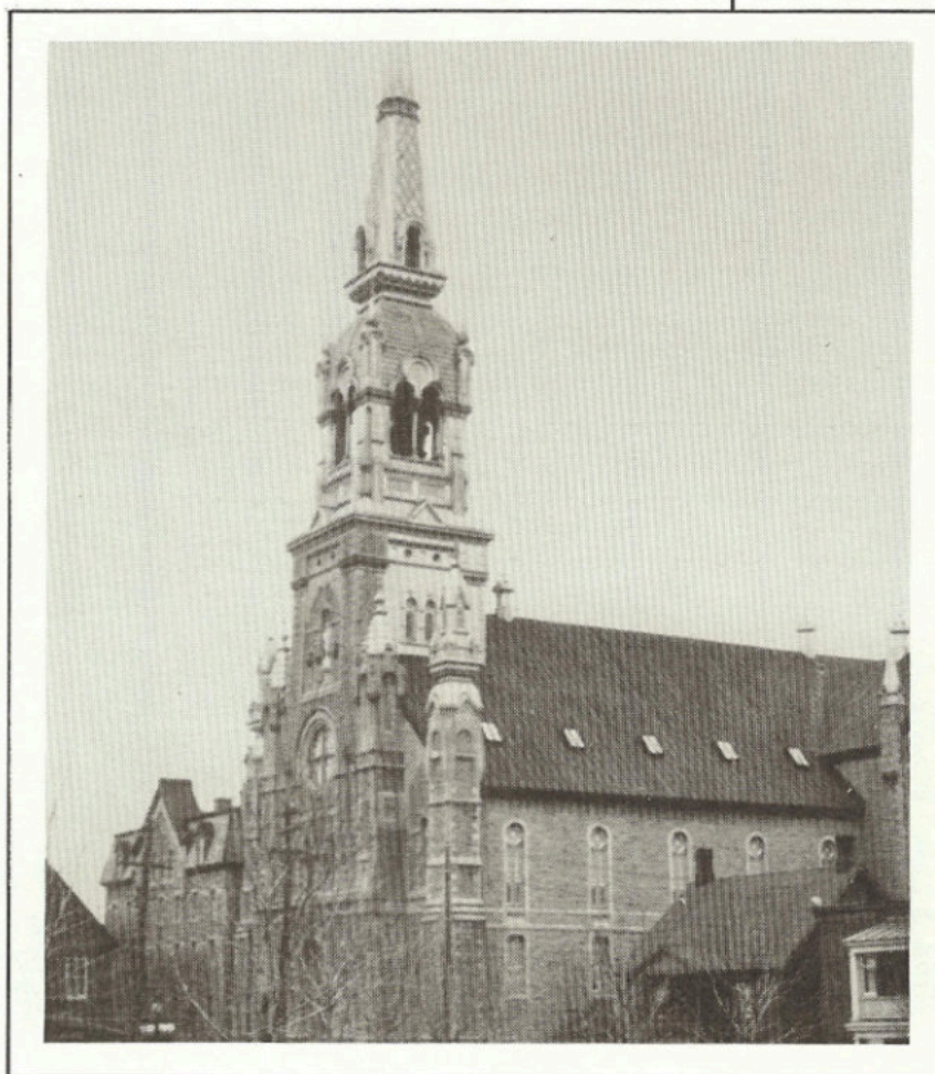
Église Notre-Dame de Grâce. ANQO, Fond «Ville de Hull».
