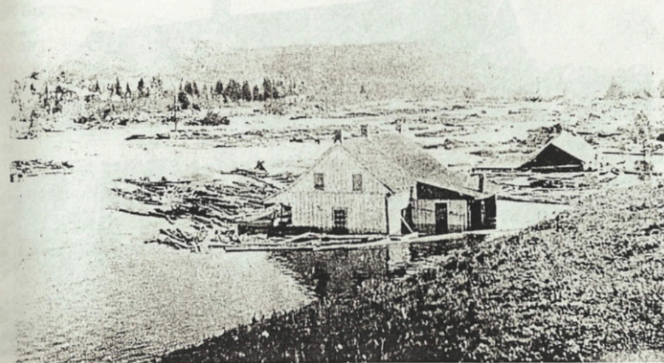
L'éboulement de Poupoire vu du nord-ouest.
