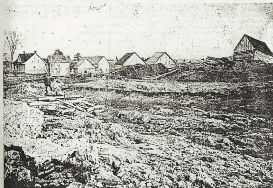
Ravages causés par l'éboulement de Poupore en 1903.
