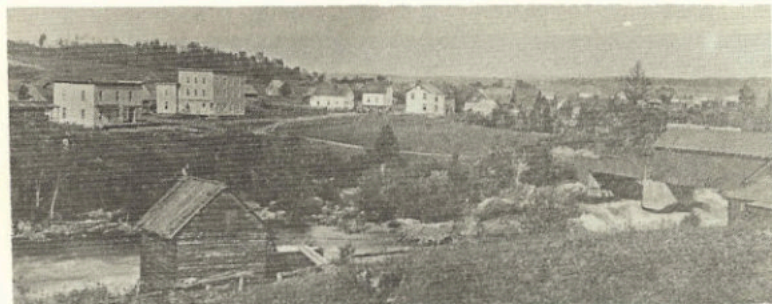
Le village prend forme; un premier magasin général se construit, suivi d'une boutique de maréchal-ferrant et d'un hôtel.
