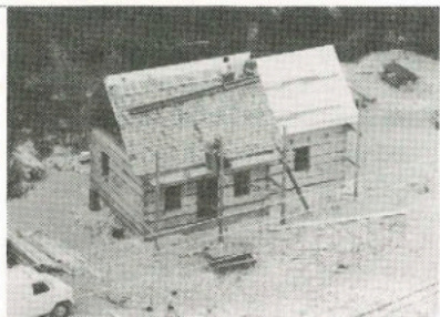
Maison pièce sur pièce bâtie à Hull (rue Montcalm) durant l'été 1979 par les Compagnons artisans du Pontiac: la pose des bardeaux. (gracieuseté d'Armand Ducharme)
